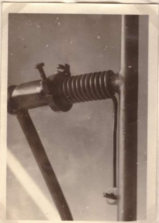
7) Die Feder ist gespannt. Bei gespannten Federn weichen die Schwingstangen nach hinten bzw. die Stützpfeiler nach vorn bis zum Anschlag aus (s. 2).
